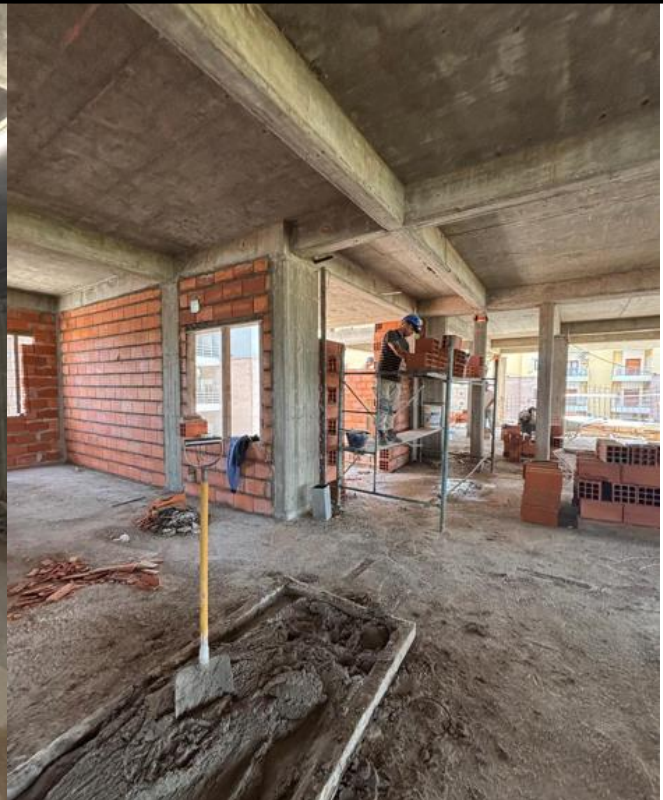
Mampostería en Primer Piso.
