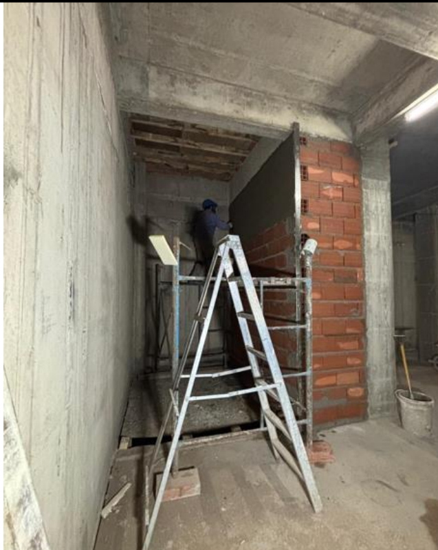
Revoque en hueco de ascensor.
